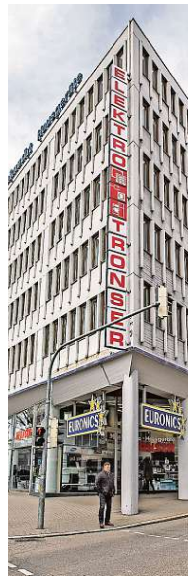
Das Tronser-Gebäude mit seiner elliptischen Stütze und den einbetonierten Verglasungen im Erdgeschoss.
